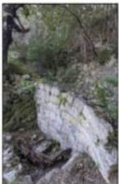
A funtana à a Leccia avant l'intervention des bénévoles. PHOTOS C. T.
