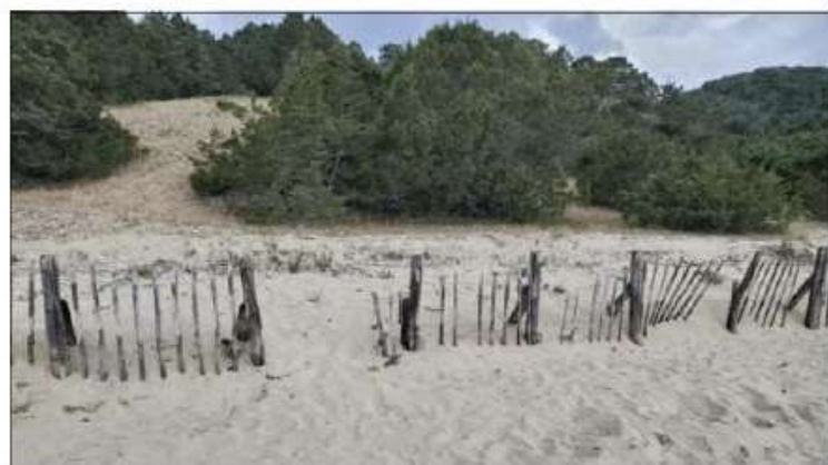
La pose de nouvelles ganivelles va permettre d'éviter l'accélération de l'érosion de la dune. Les travaux vont débuter après la saison estivale.
