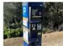
Quatre horodateurs ont été installés au total.
