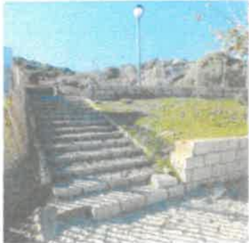
Excavter en pierre à démolir; accès plage à condenser.
